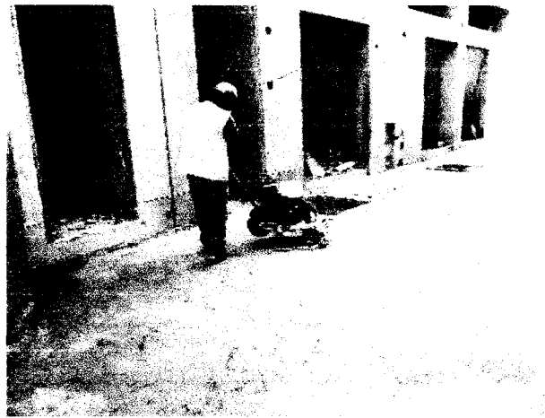
Foto 08: Relleno con material propio y compactación. Exterior de zona de subestación
